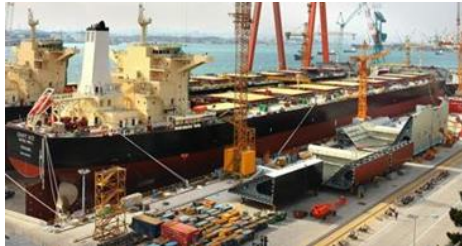
[사진3. 크레인을 통한 자재 운반 작업(통로 확보전)]
