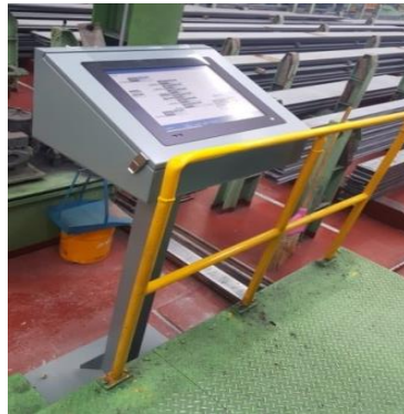
[사진1. 공장내 설치된 MIU]
